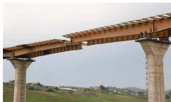
Fig. 9: Varo carpenteria metallica
