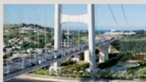
PONTE SULLO STRETTO
