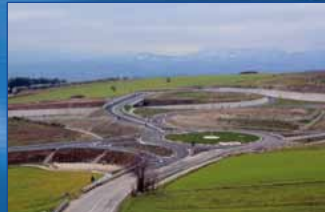
Svincolo n.1 sulla ex strada statale 212 per Pietrelcina
