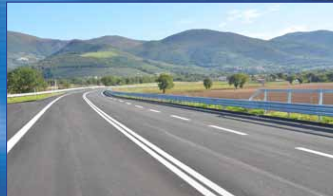
Asse principale allo svincolo per San Giacomo
