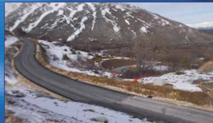
Nuovo asse stradale della strada statale 696, lato Rocca di Cambio - in fase di esecuzione
