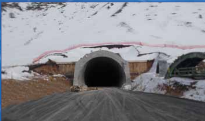
Galleria "Serralunga", imbocco lato Campo Felice - in fase di esecuzione
