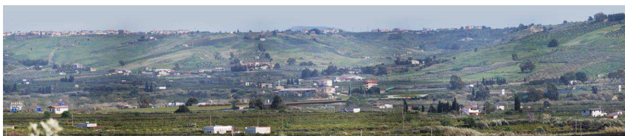
Fig. 14 – Vista panoramica del nuovo Ponte Verdura dalla S.S. 115 Lato Sciacca
