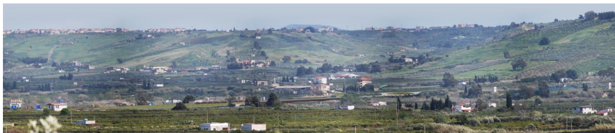
Figura 5 – Vista Panoramica del nuovo Ponte Verdura dalla S.S.115 lato Sciacca
