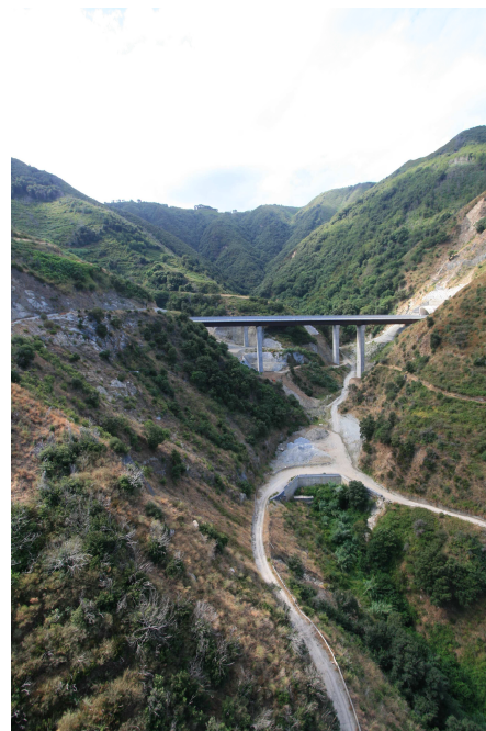
Fig.4 - Autostrada A3 Salerno - Reggio Calabria. Macrolotto 5. Viadotto Costa Viola
