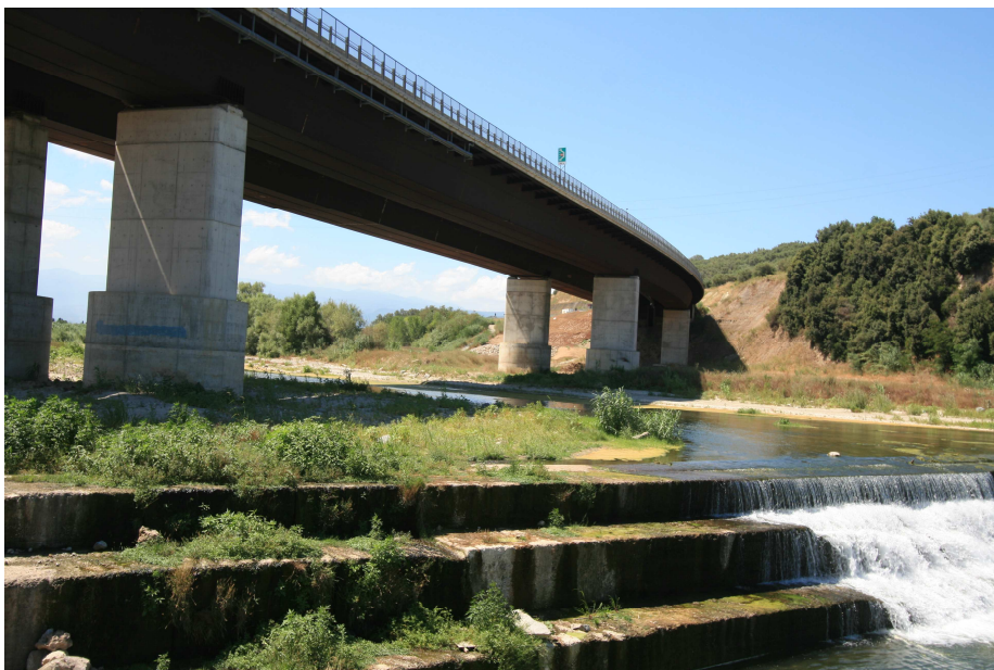
Fig. 2 – Autostrada A3 Salerno - Reggio Calabria. Macrolotto 5 dal km 393+500 (svincolo di Gioia Tauro escluso) al km 423+300 (svincolo di Scilla escluso). Viadotto Petrace
