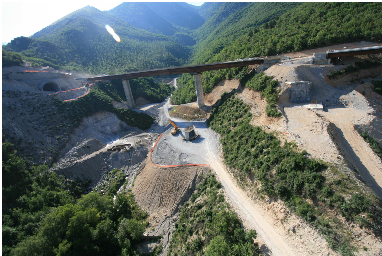
Fig. 1 – Autostrada A3 Salerno - Reggio Calabria. Macrolotto 3 - Parte III dal km 173+900 al km 185+000. Viadotto Caballa
