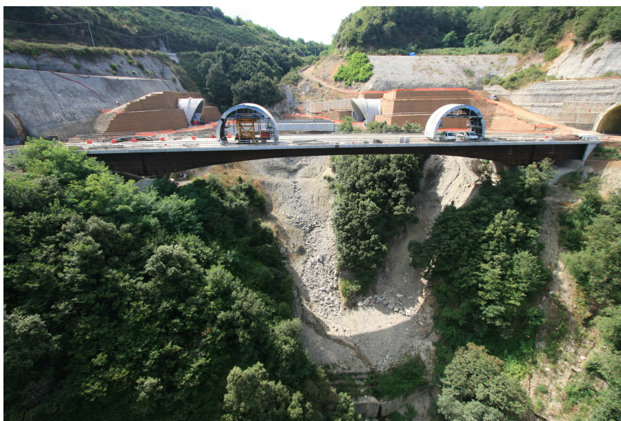
Fig. 5 – Autostrada A3 Salerno - Reggio Calabria. Macrolotto 5. Viadotto Gazziano
