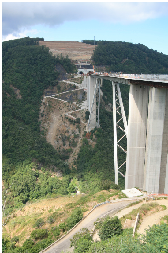
Fig. 3 – Autostrada A3 Salerno - Reggio Calabria. Macrolotto 5. Viadotto Sfalassà
