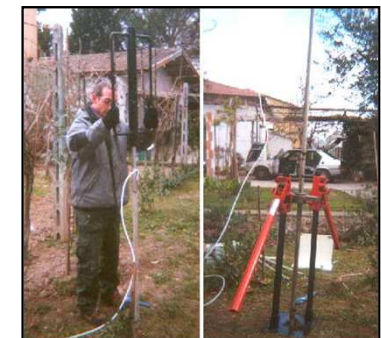
Esecuzione di log verticali
