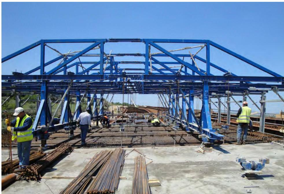
Figura 6 - Attrezzatura di getto nella fase di posa in opera delle armature
