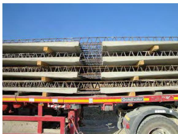
Figura 9 - Costruzione e trasporto predalle a spessore variabile
