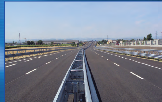
Asta principale viadotto "Via Mattei"
