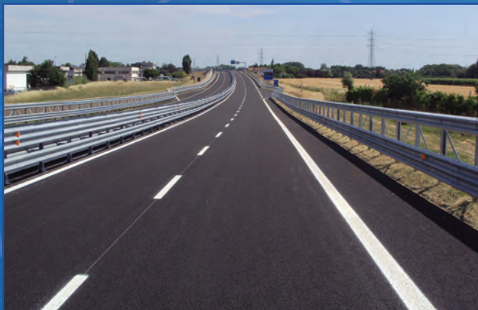
Asta principale viadotto "Svincolo via Fermi"
