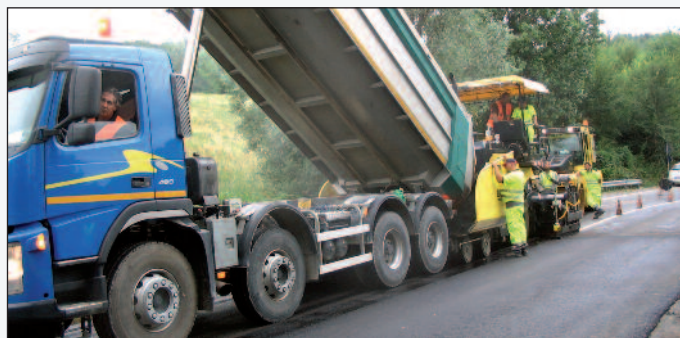
Figura 3 - Lo scarico del conglomerato bituminoso per alimentare la vibrofinitrice
