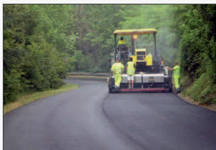
Figura 4 - La stesa in corrispondenza del tratto in curva
