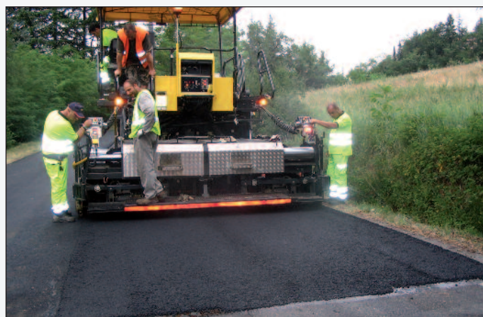
Figura 2 - Un particolare della stesa del conglomerato bituminoso
