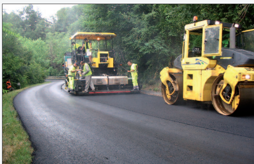
Figura 1 - La stesa del conglomerato bituminoso
