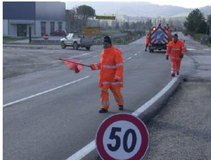
Figura 1 - Attività in corso in un cantiere stradale
