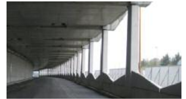
Figura 2 – Tunnel artificiale semi-aperto costruito per ridurre gli effetti di rumore lungo l'autostrada A 86, a sud di Parigi.
