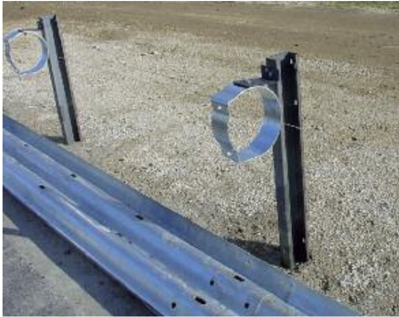
Figura 1 - Barriera in fase di montaggio
